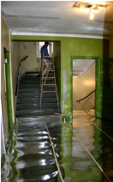
Skyddstäckning inför målning.
